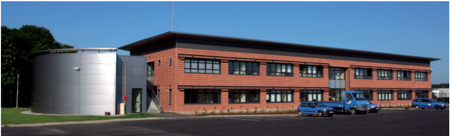
Vue générale bâtiment tertiaire
