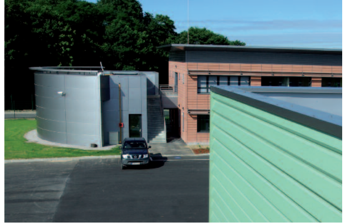
Jonction salle de contrôle
