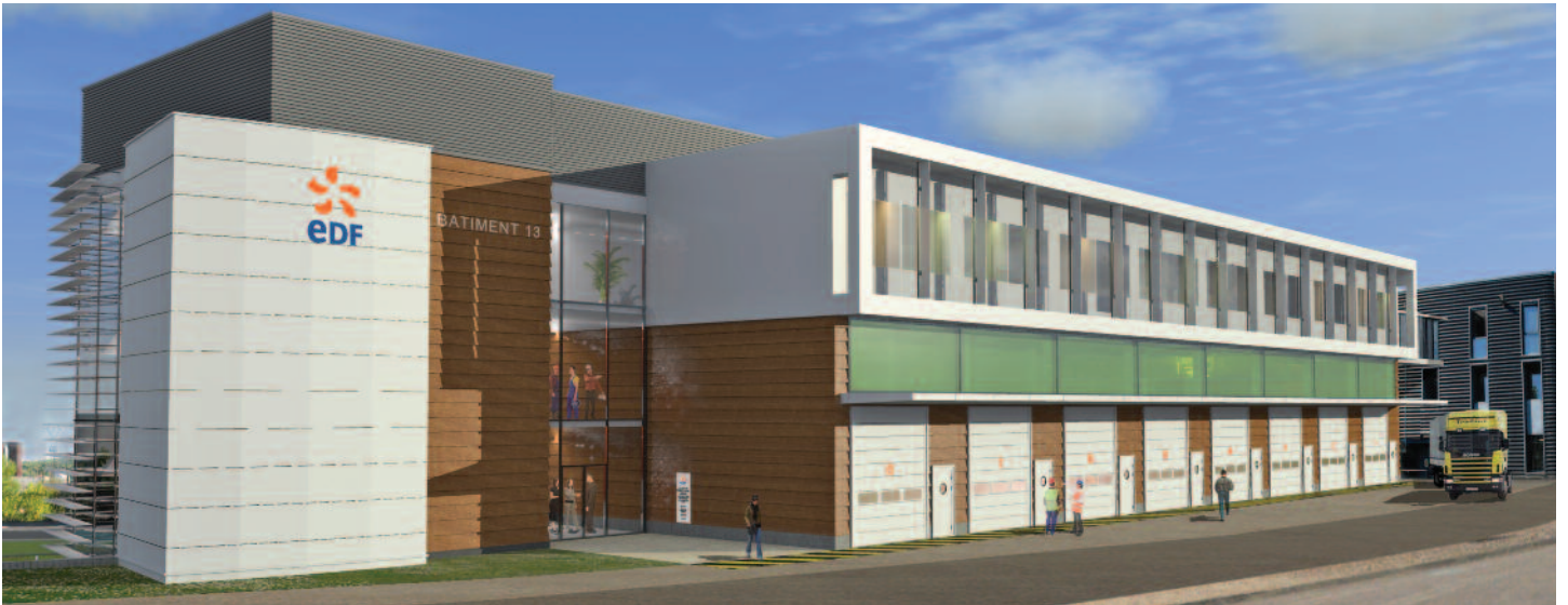
Bâtiment N° 13 vue générale depuis la rocade d'accès
