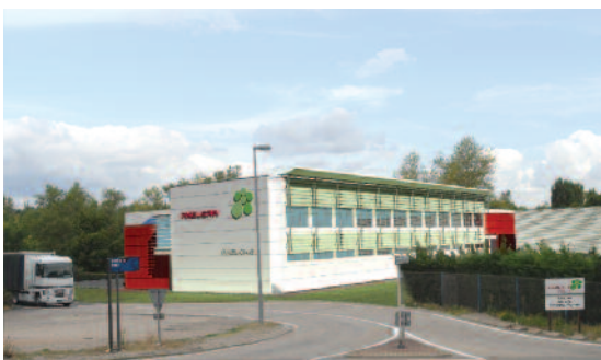
Site « Procédés propres » - Solaize (69) Détail entrée du site
